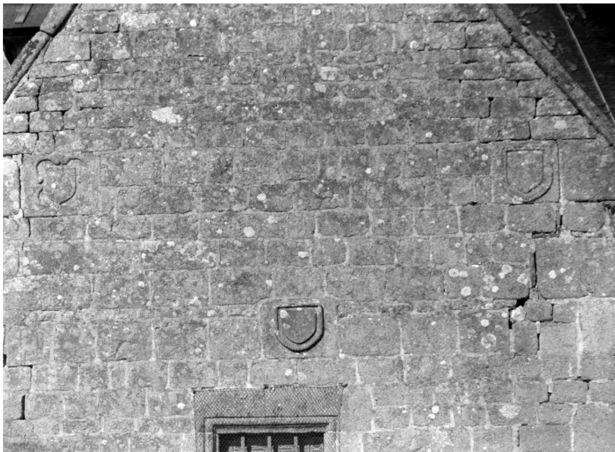
Élévation Sud, chapelle des Fonts : détail des écus
