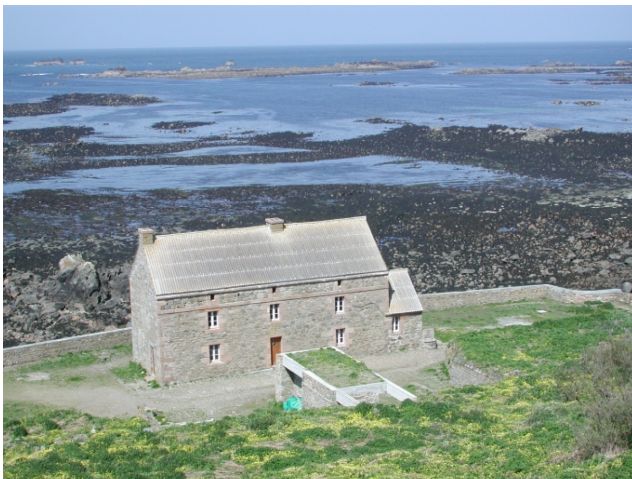
Vue générale de la caserne
