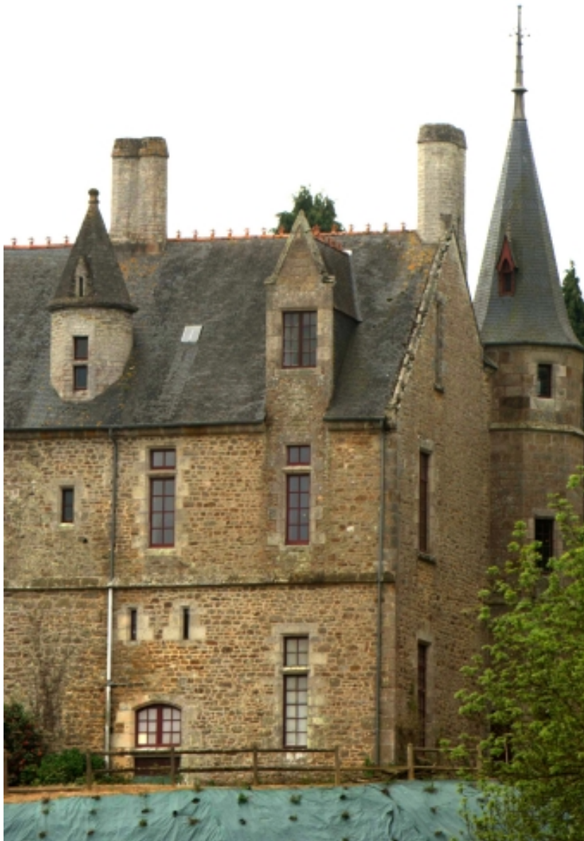
Château, façade donnant sur la Rance, détail
