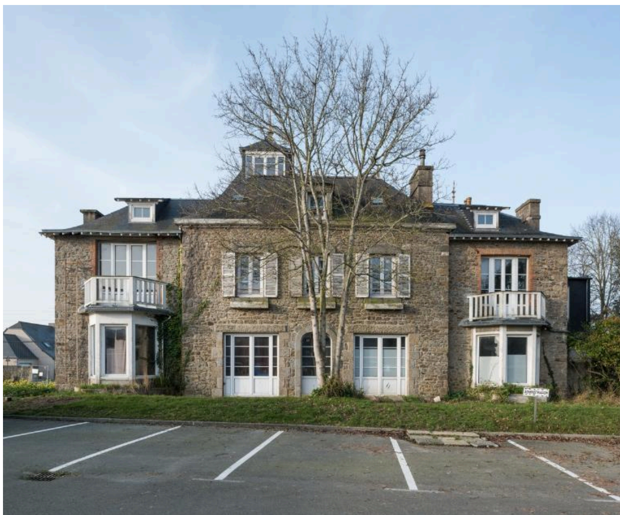
Façade est, vue de face
