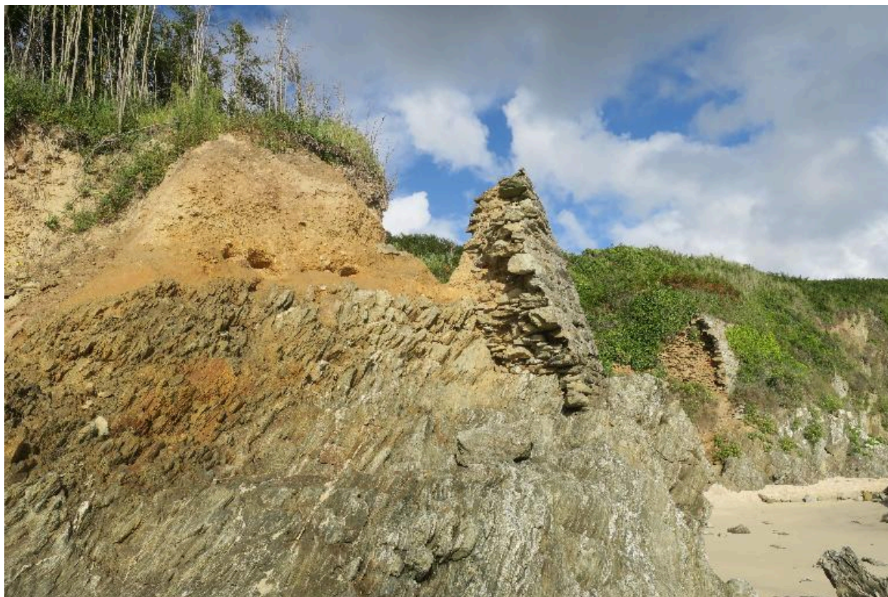
Locmaria, Grands Sables, extrémité ouest effondrée.
