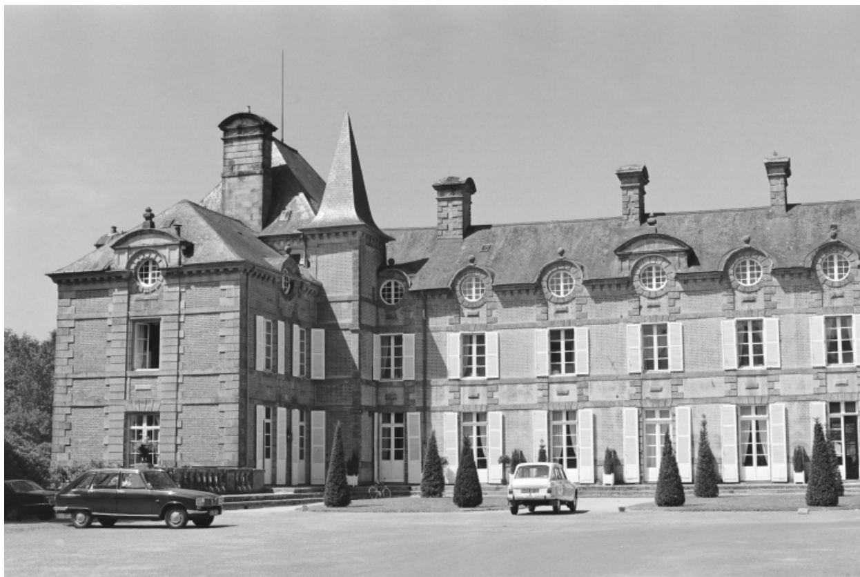
Façade sud : vue générale
