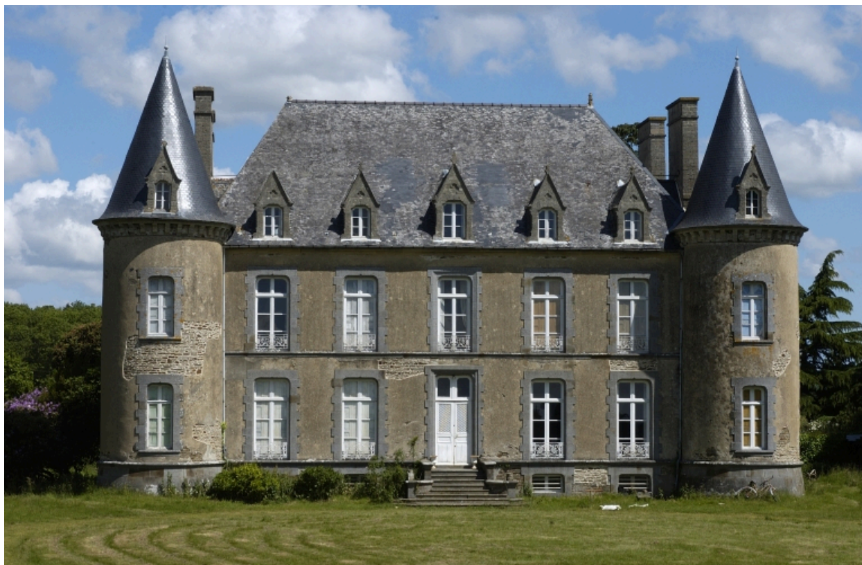
Logis ; vue générale sud
