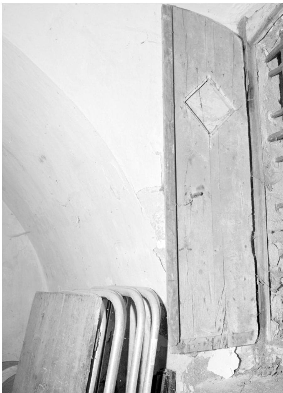
Cachot du rez-de-chaussée sud, détail fenêtre.
