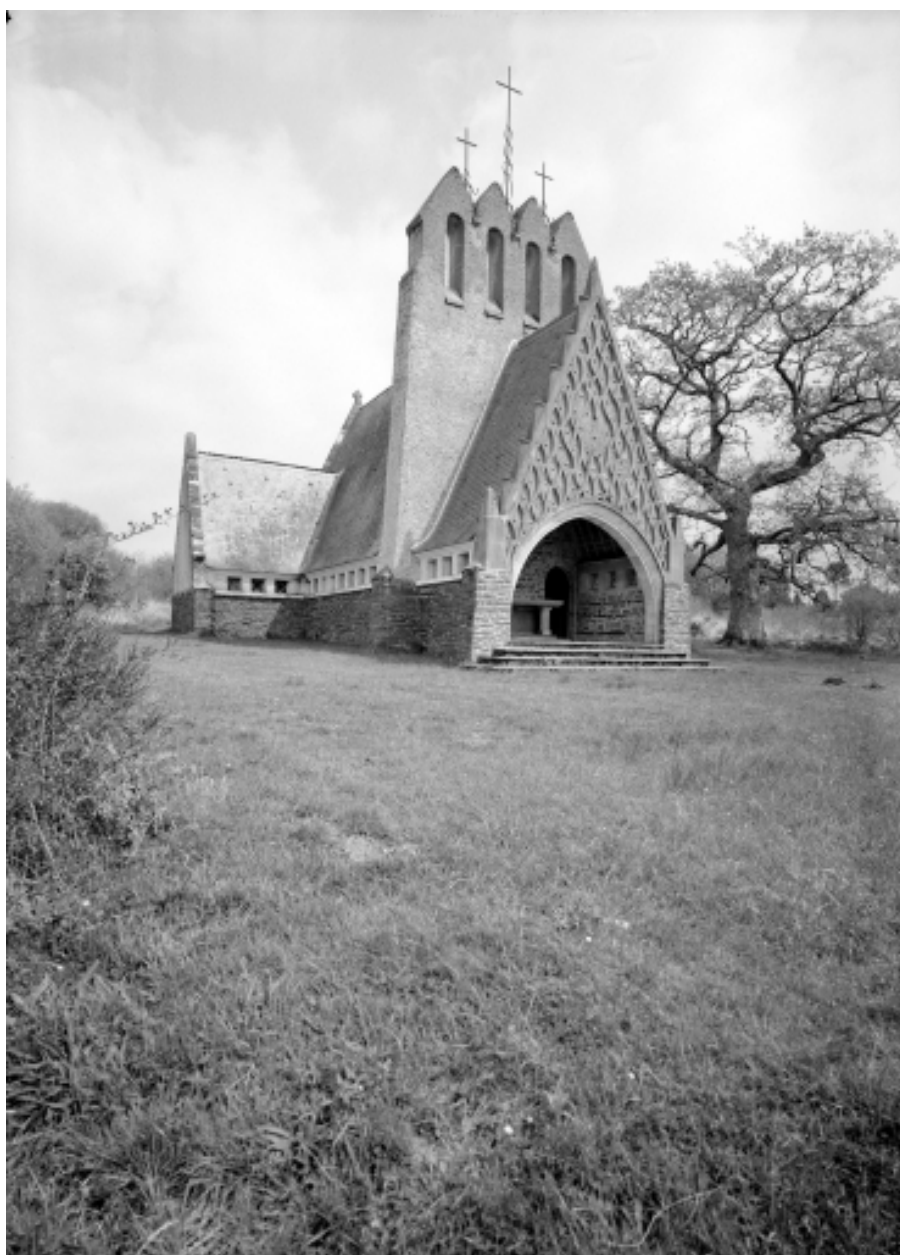
Elévation Nord-Ouest : vue générale
