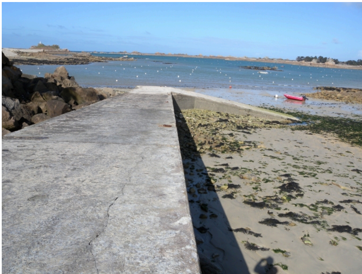
Vue de la forme générale de la cale neuve du Port-Blanc
