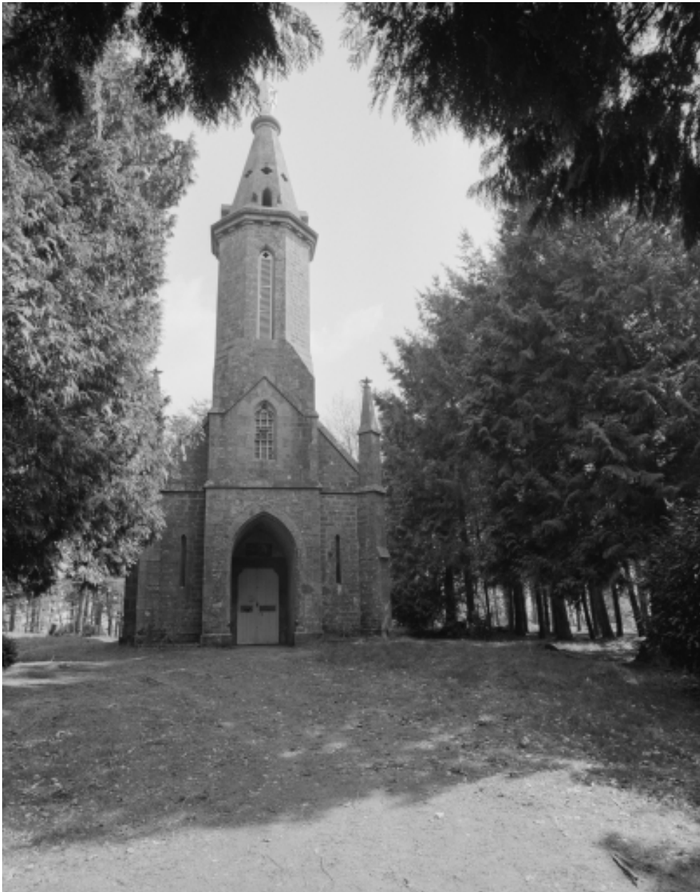
Elévation Ouest : vue générale
