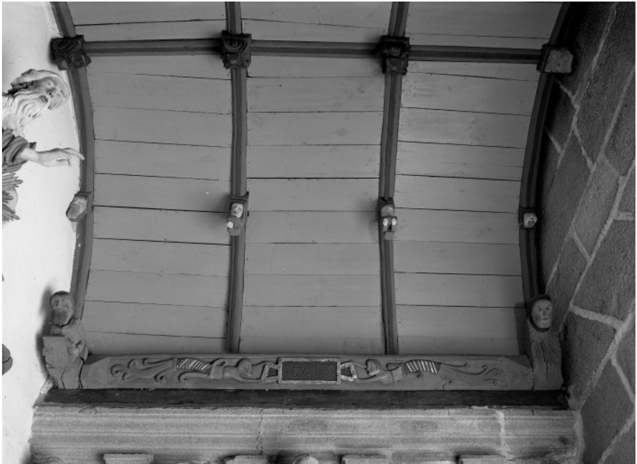
Plomodiern, église paroissiale Saint-Mahouarn : porche sud, lambris et sablière, côté est, état en 1970
