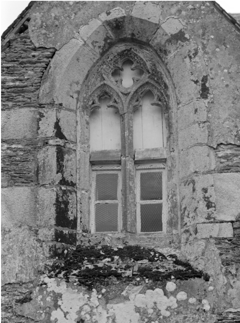
Chapelle Saint-Golven, sacristie, pignon nord : fenêtre (état en 1984)
