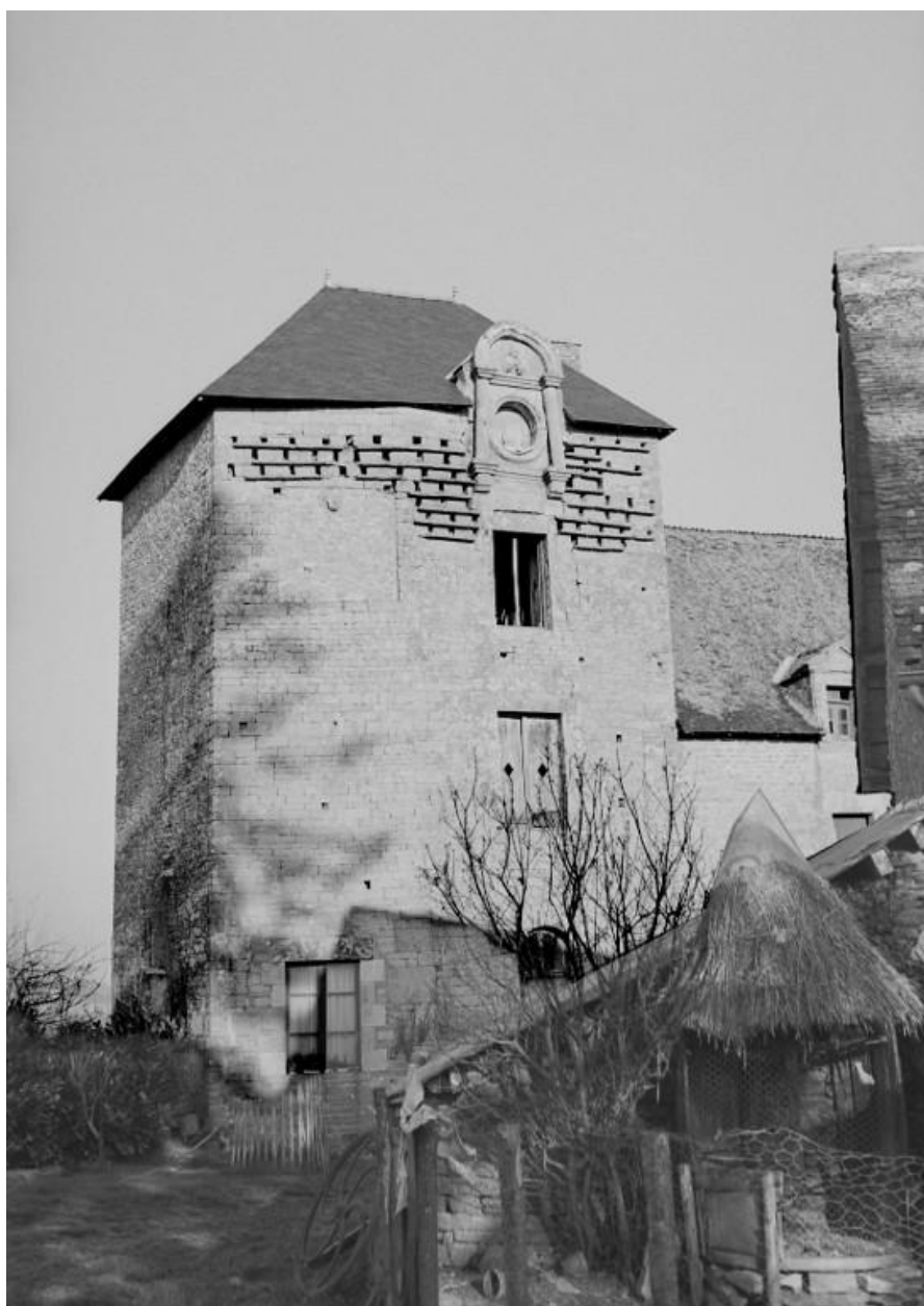
Elévation de la tour sud
