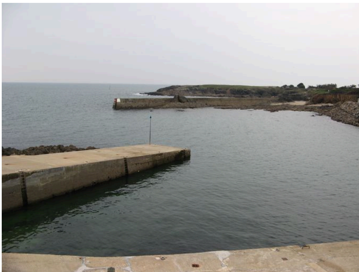
Cales et môle à l'entrée du port de Doëlan
