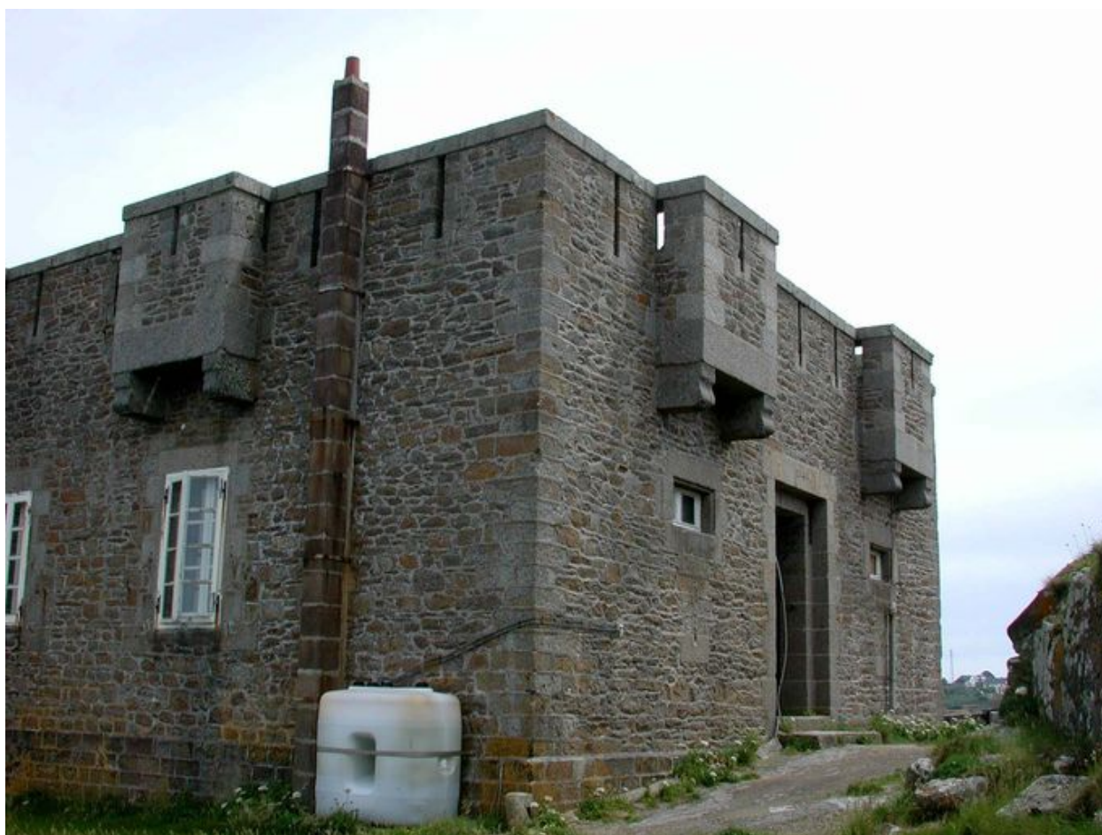
Vue du réduit de batterie de côte de la pointe de Kermorvan, angle nord-ouest
