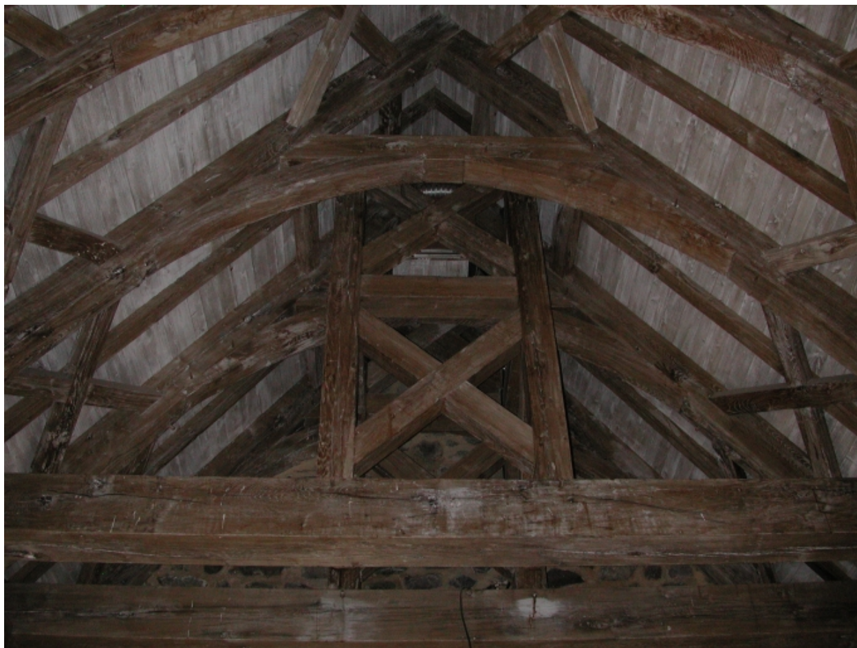
Vue de la charpente intérieure de la chapelle, en plein cintre, avec un seul vaisseau
