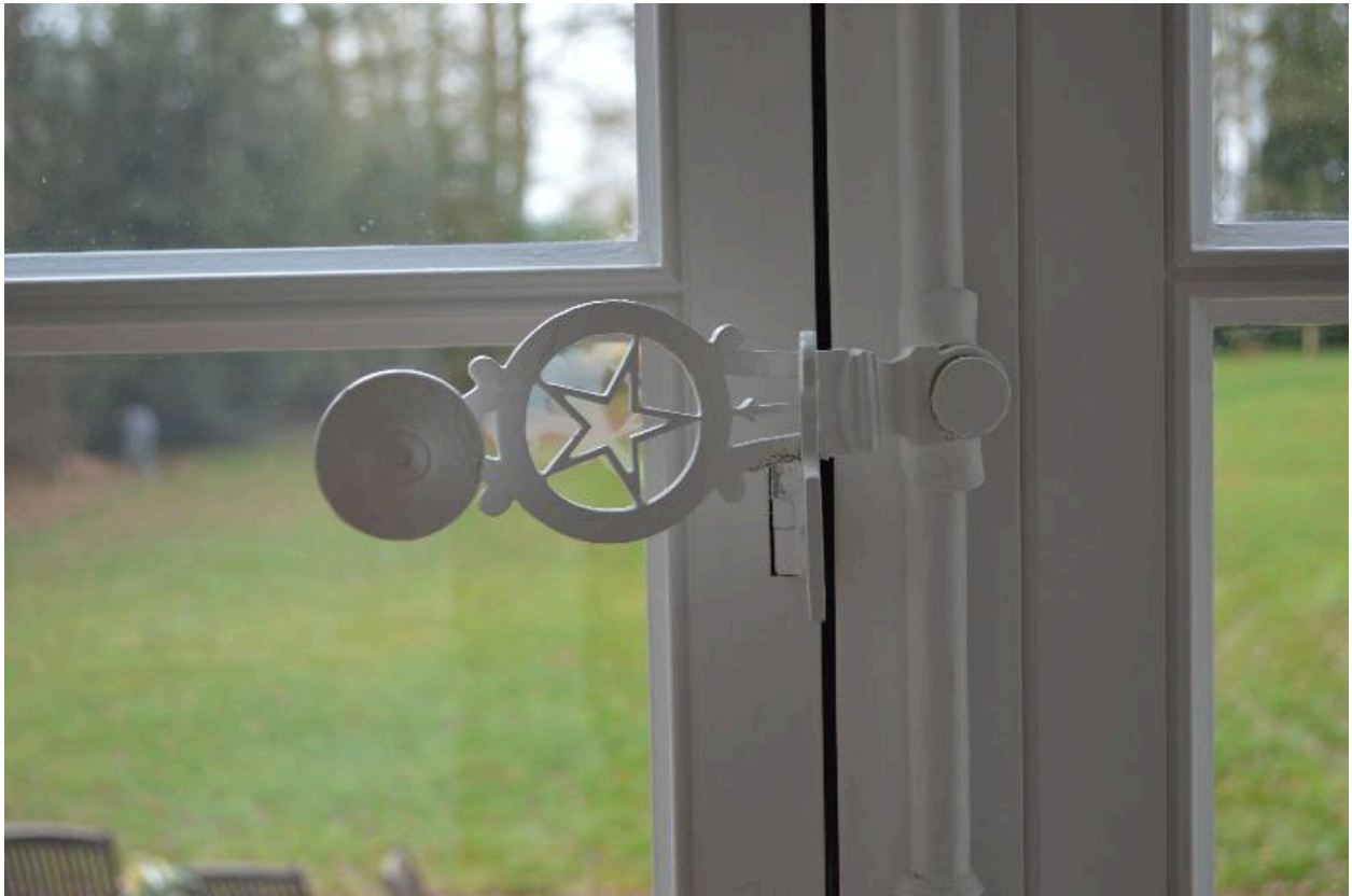
Porte-fenêtre : détail d'une crémone de ferronnerie
