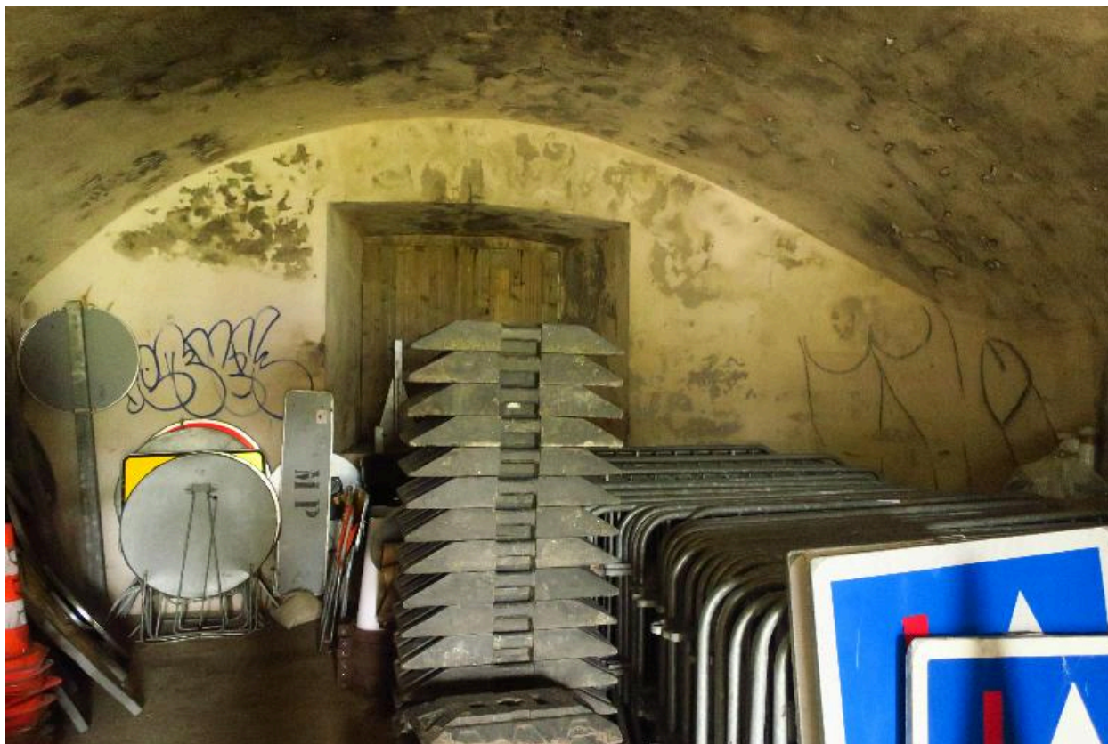
Le Palais, enceinte urbaine, réduit C, deuxième travée de gauche.
