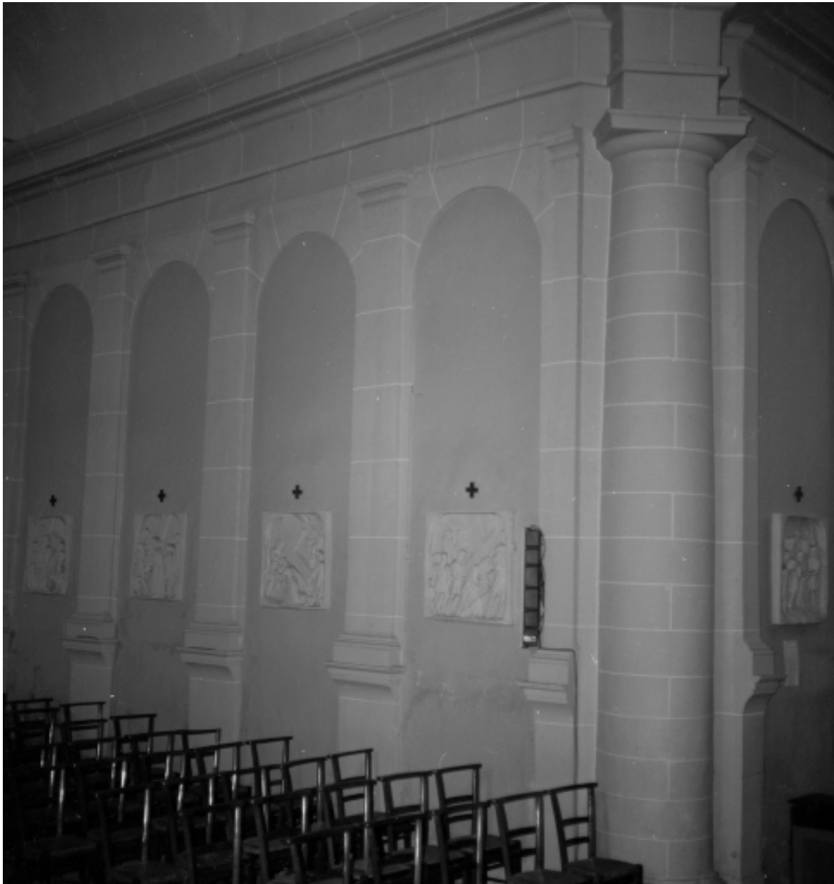
Nef, élévation intérieure, côté nord, vue générale.
