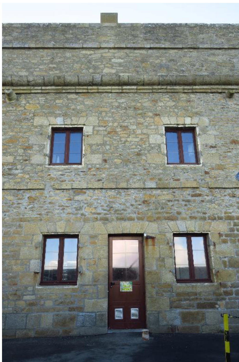
Saint-Pierre-Quiberon, fort de Penthievre, caserne défensive, détail de la façade nord-ouest.
