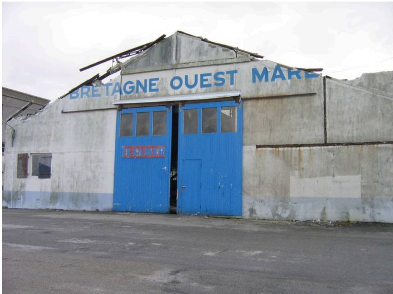
Bâtiment d'Ouest Marée en cours de démolition (décembre 2005)
