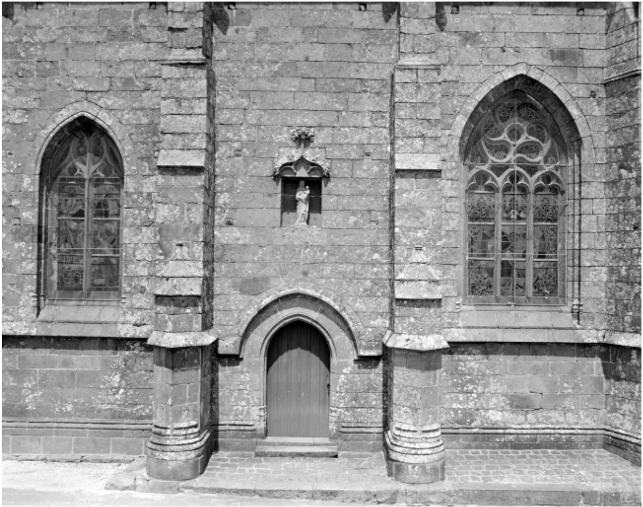
Elévation Sud, porte Est : vue générale
