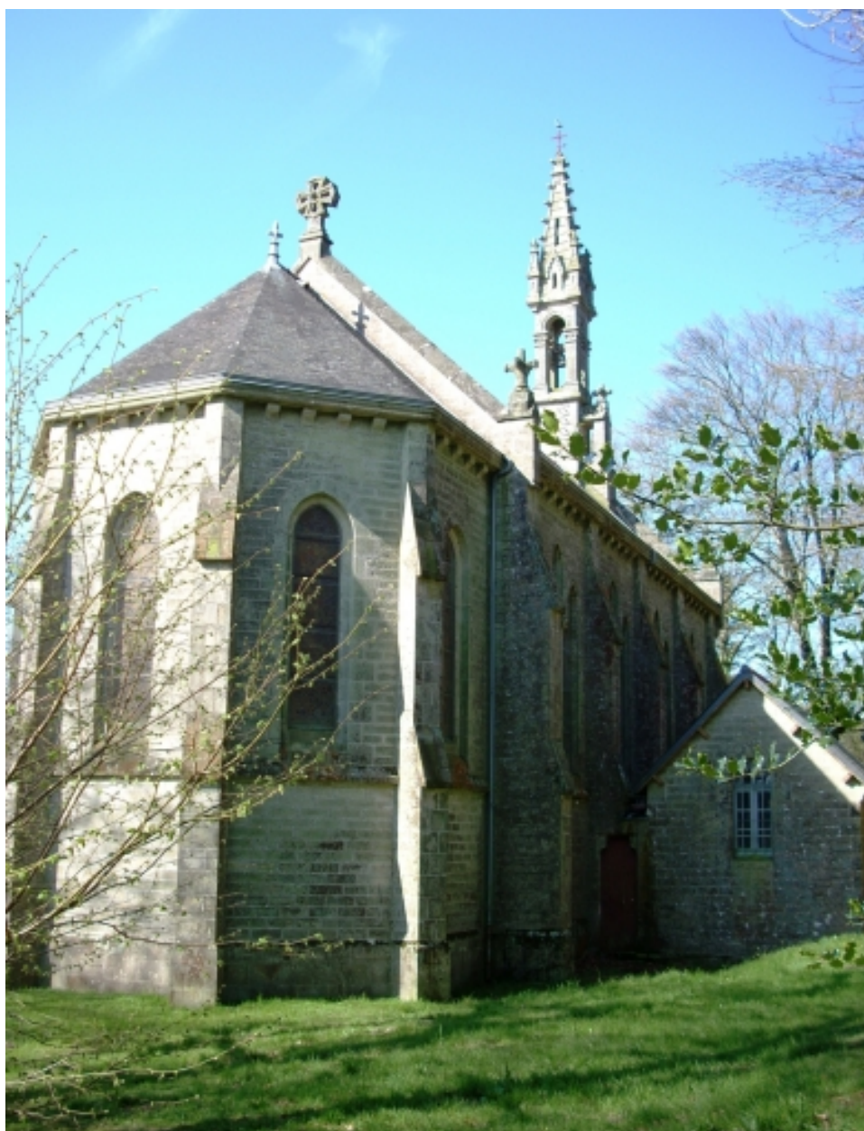
Plomodiern, chapelle Saint-Corentin : vue générale nord-est
