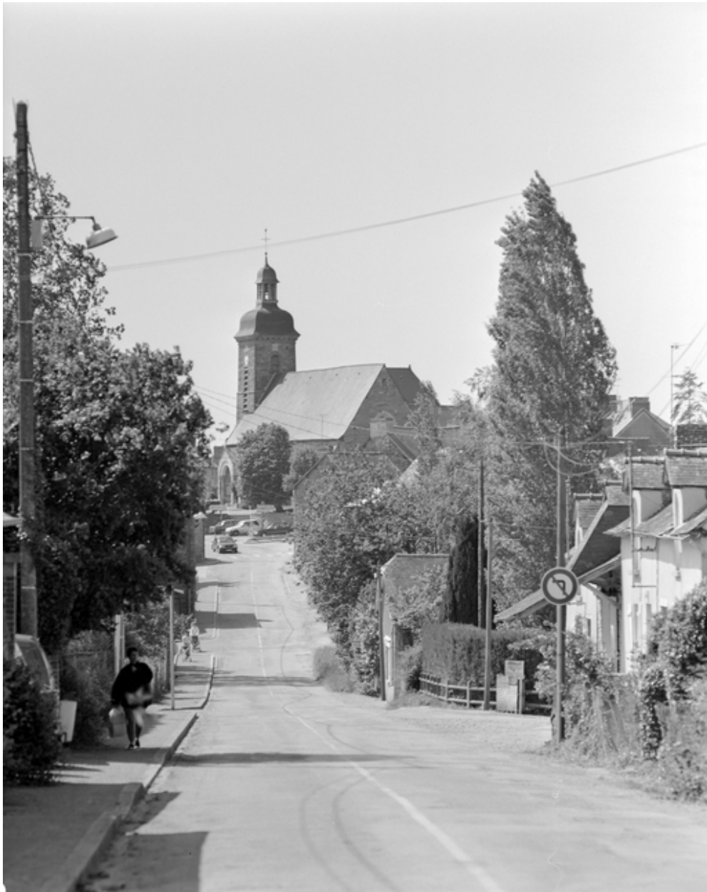
Elévation Sud-Ouest : vue générale
