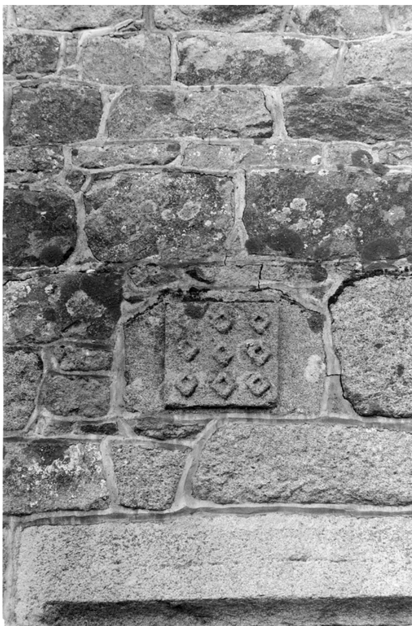
Vue de détail du blason en façade sud
