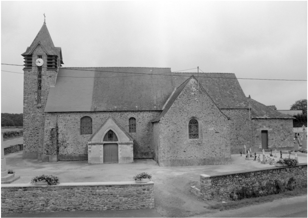
Elévation sud : vue générale
