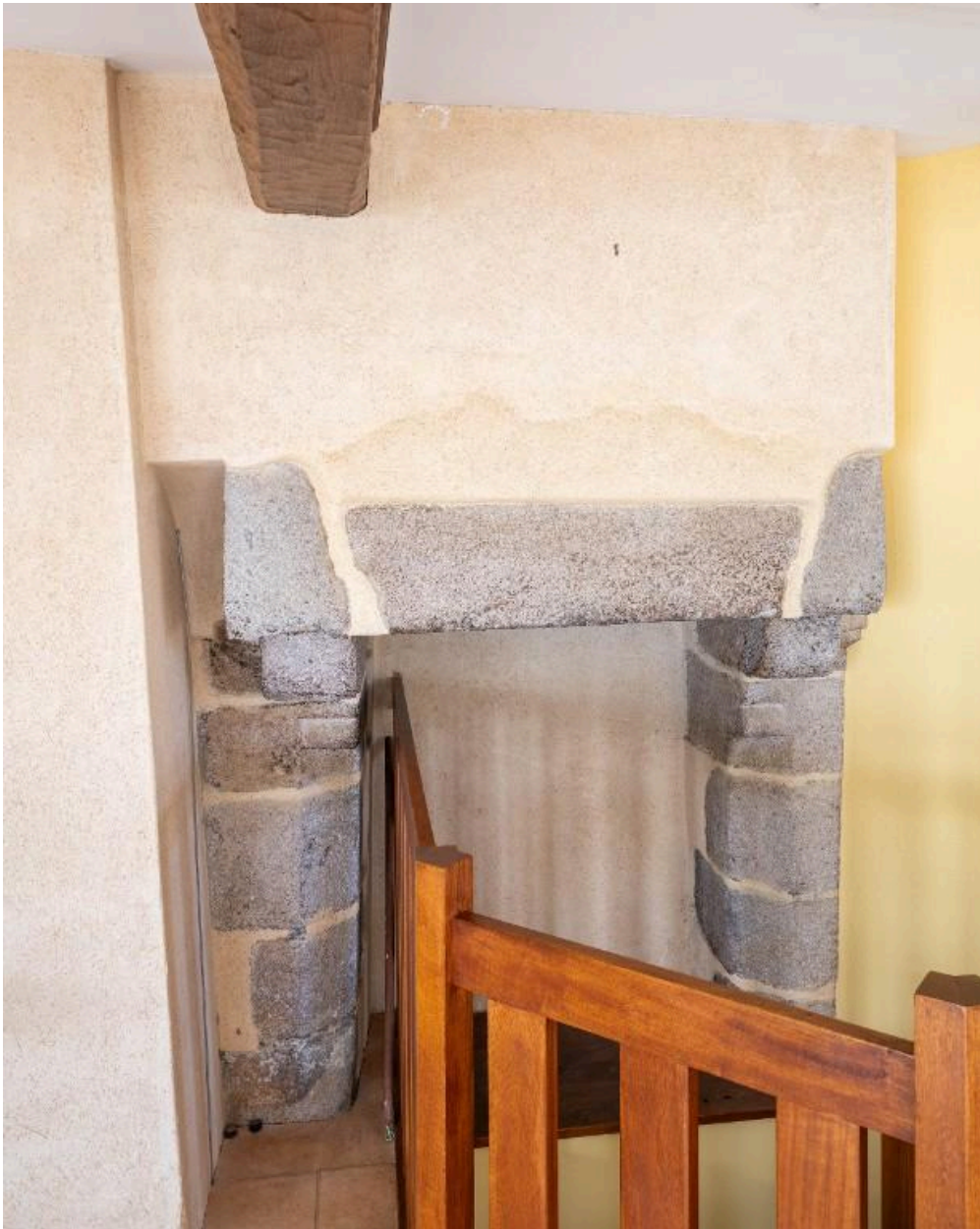
Cheminée du premier étage dans le gouttereau nord.
