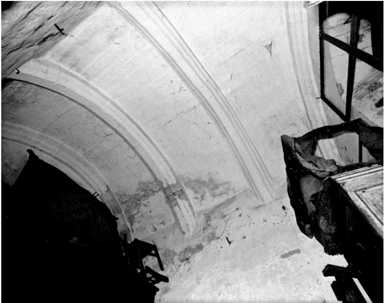
Vue de détail de la voûte.
