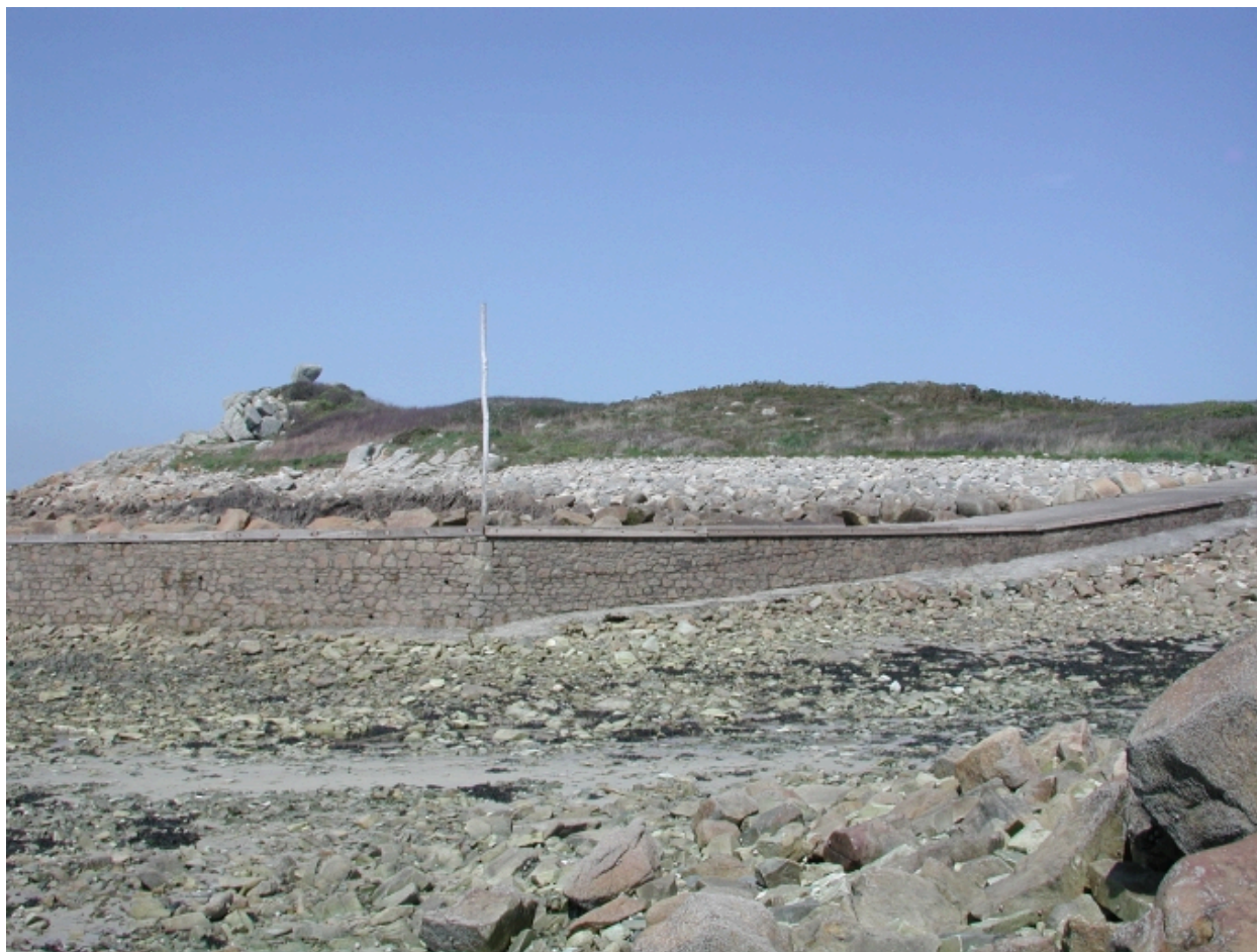
Vue des premiers tronçons du quai, avec son recouvrement en béton
