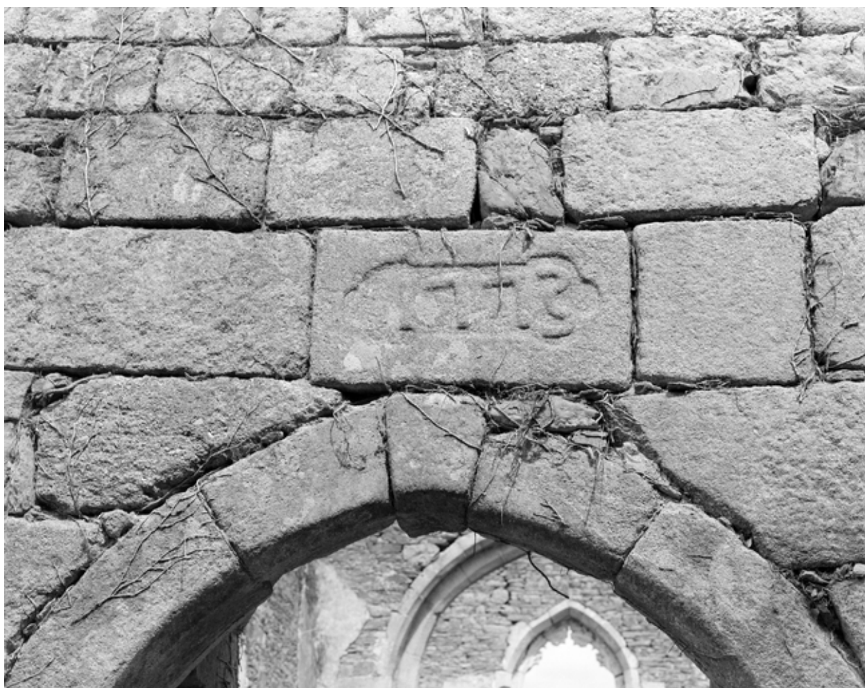
Elévation ouest, détail du cartouche portant la date 1773 au-dessus de la porte
