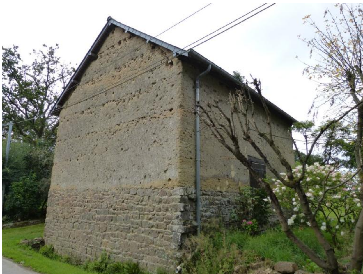
grange vue générale nord ouest
