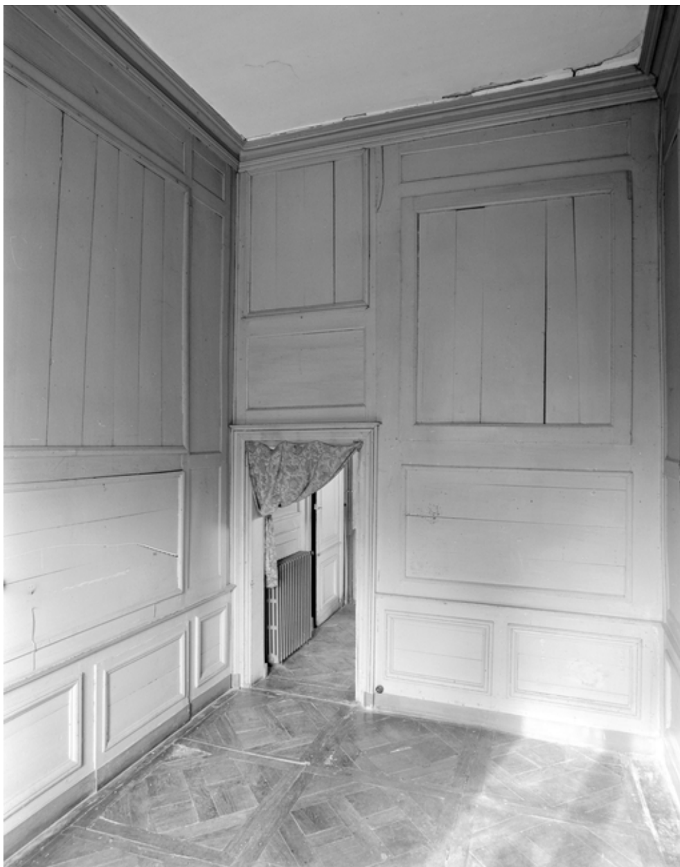
Rez-de-chaussée, chambre nord, vue générale vers le sud-ouest.
