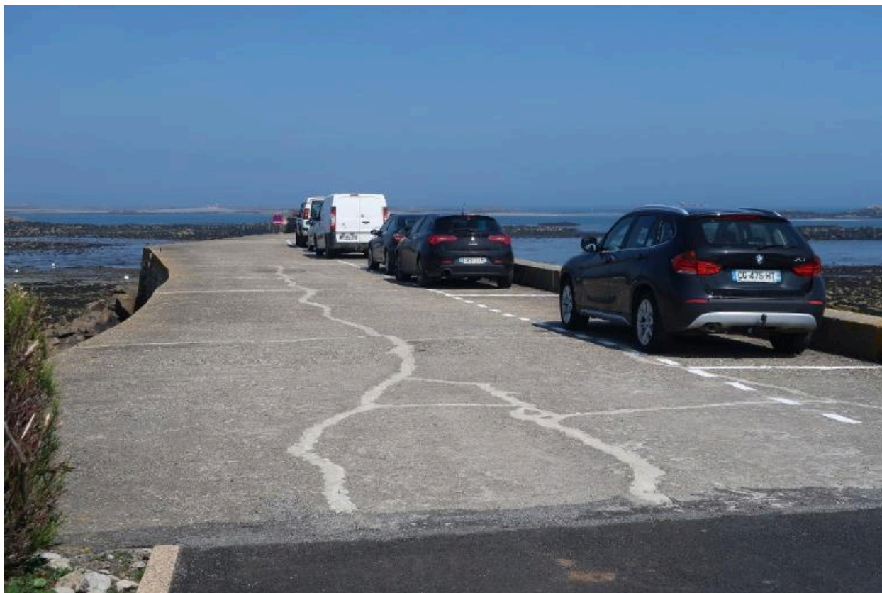
Vue de la jetée de Pen ar Vill et de sa plate-forme à usage, entre autres, de parking
