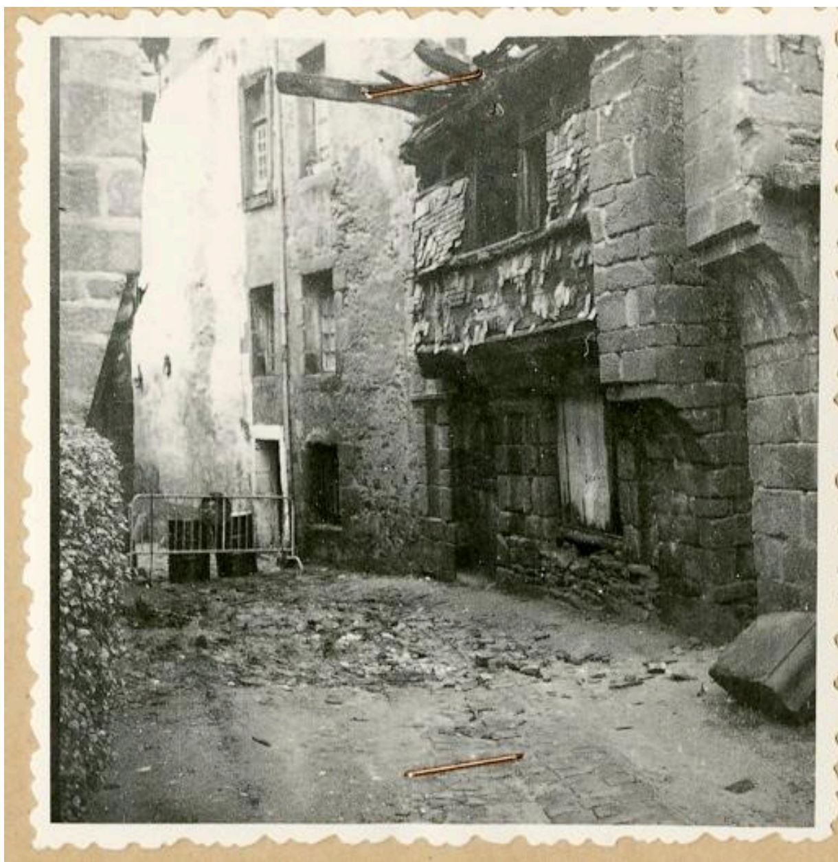
3 rue Neuve : façade en pan de bois avec essentage d'ardoises avant sa destruction
