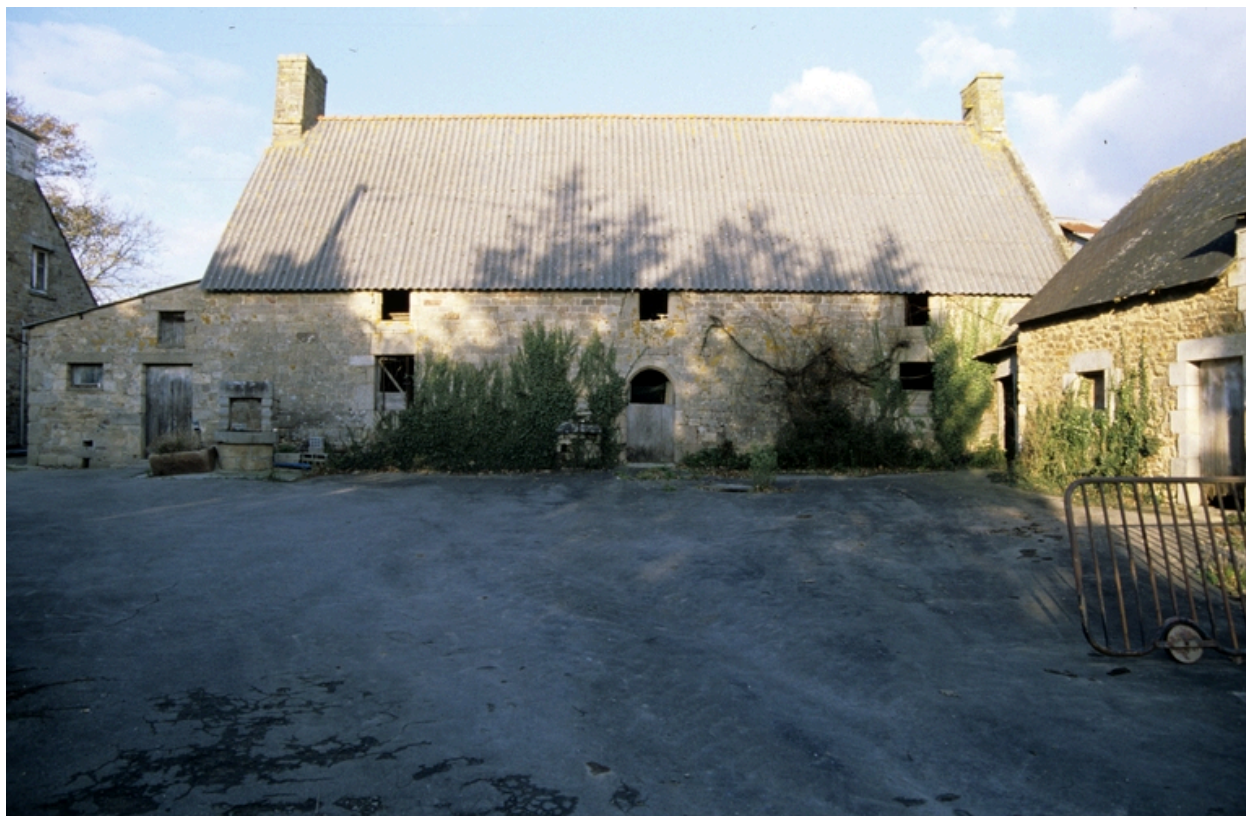
Elévation sud, vue générale.
