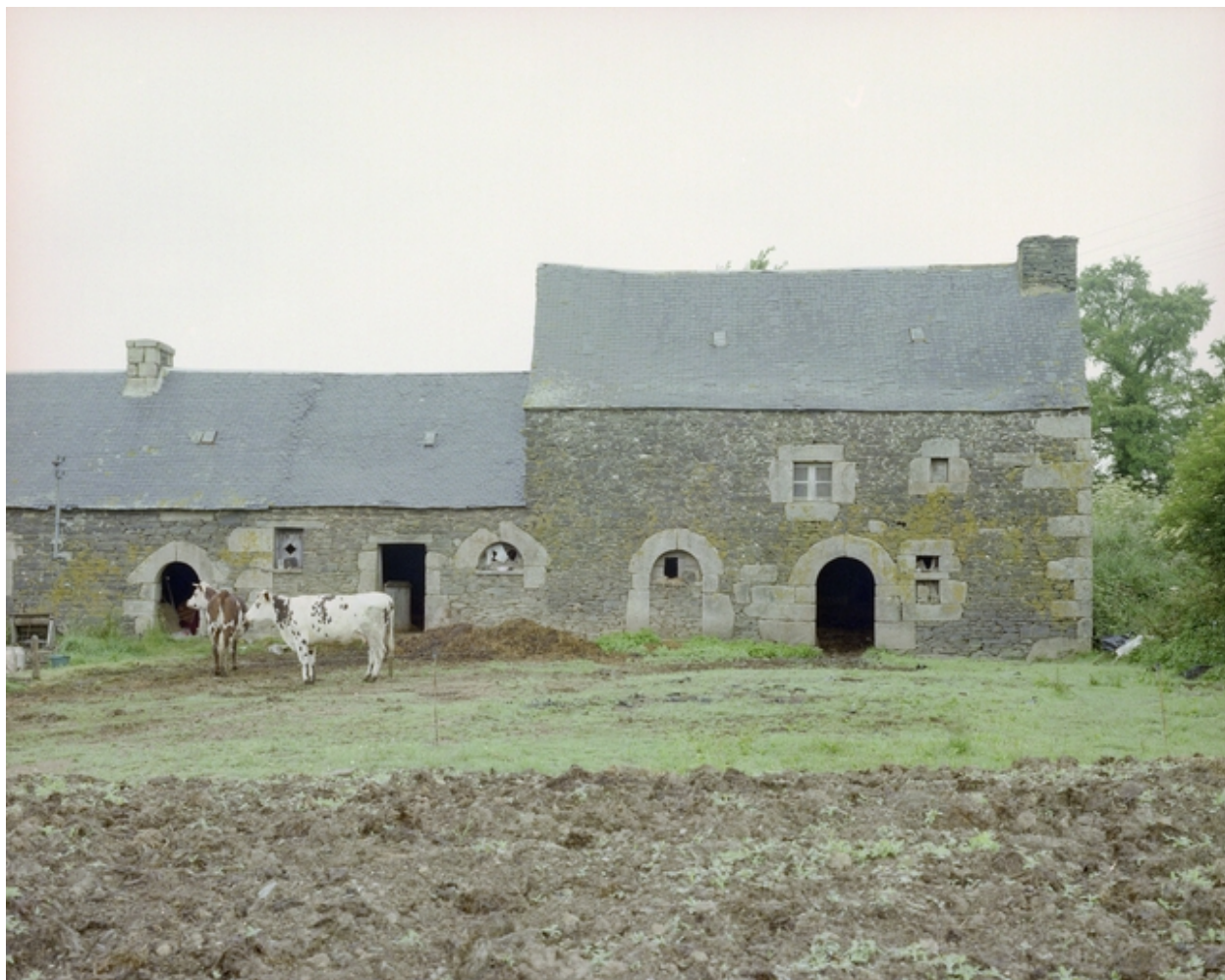
Maison 1 : vue générale sud
