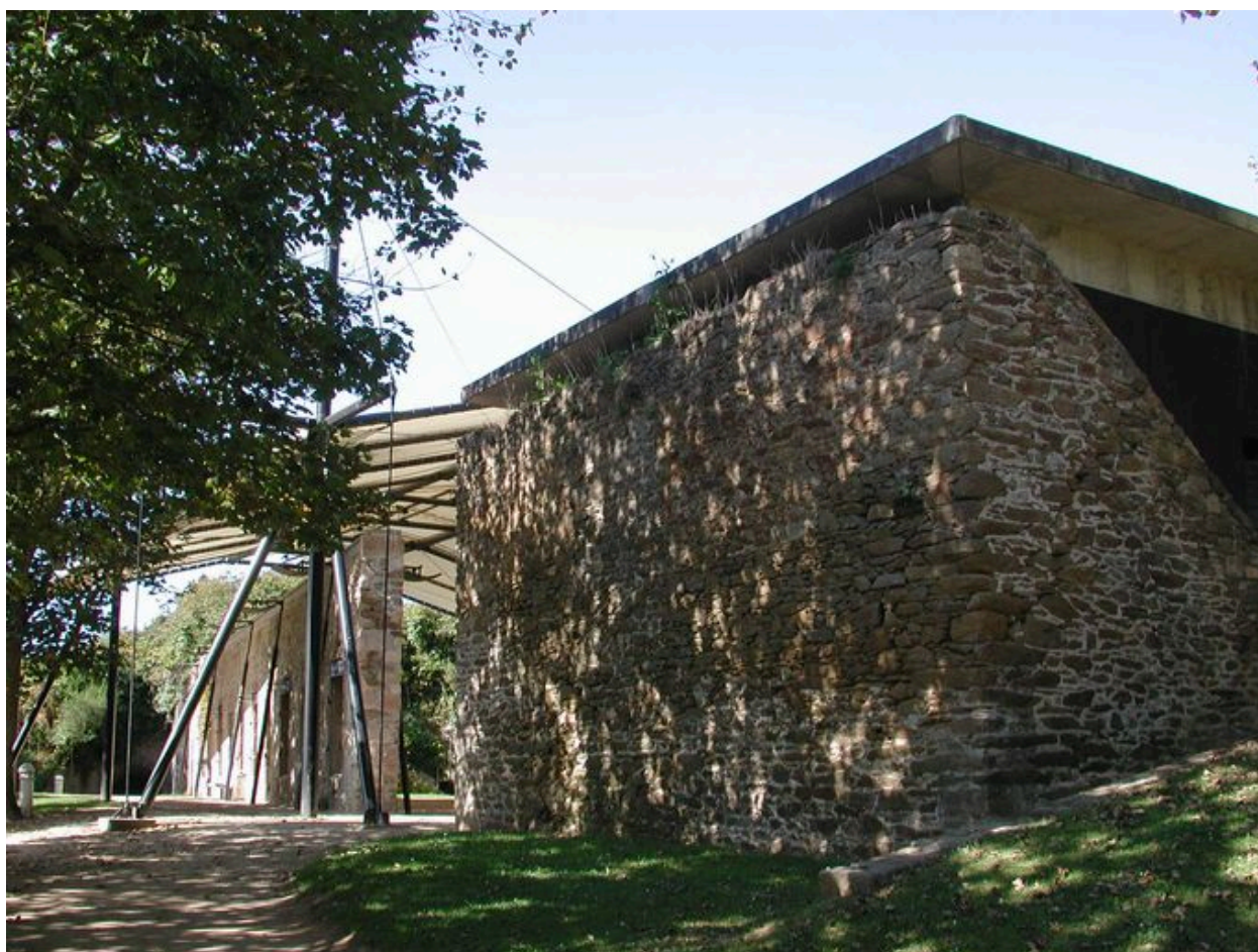
Vue du fort du Dellec : caserne
