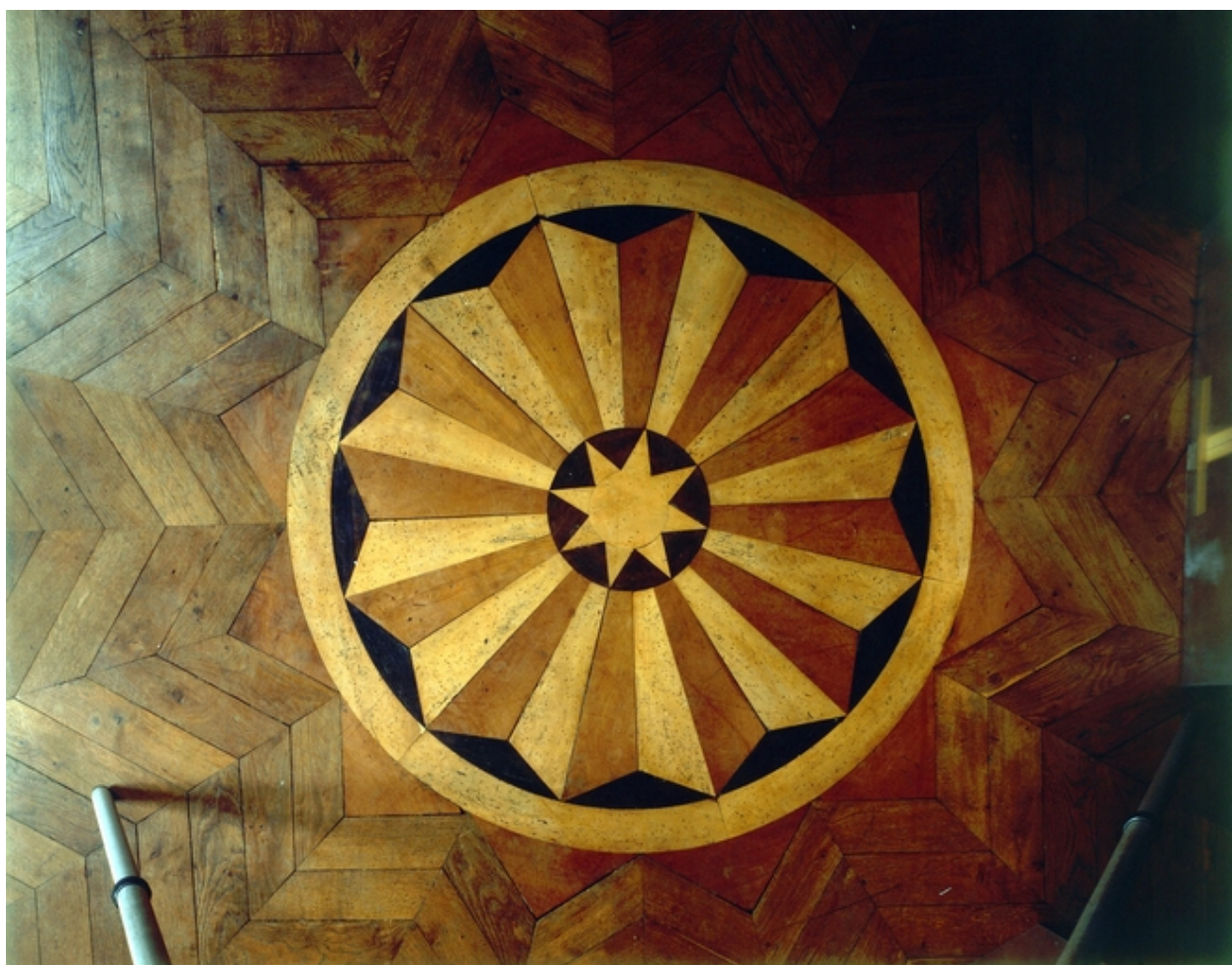
32 rue Nationale, 1er étage, salle sur rue, parquet, motif central, vue de détail.
