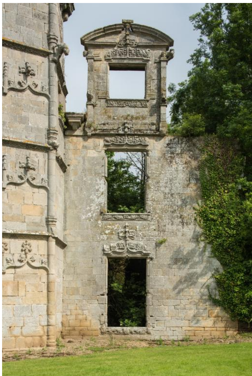
Le château, partie est : travée
