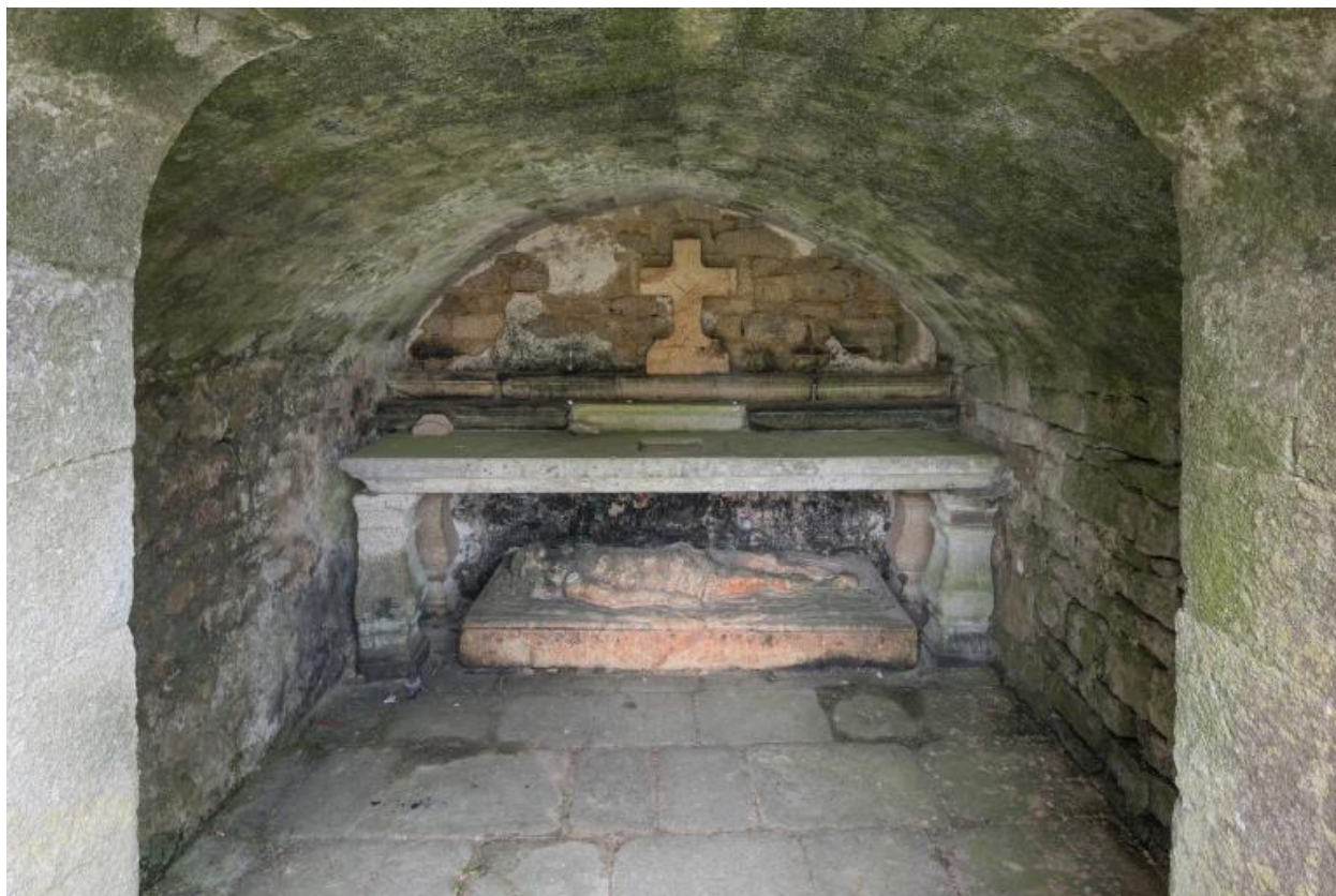
Vue générale : voûte de l'escalier de la scala sancta.
