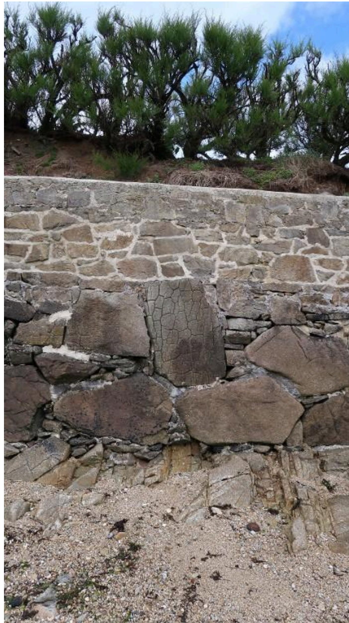
Jetée de Pen-Ar-Vil : substrat rocheux, maçonnerie et joints
