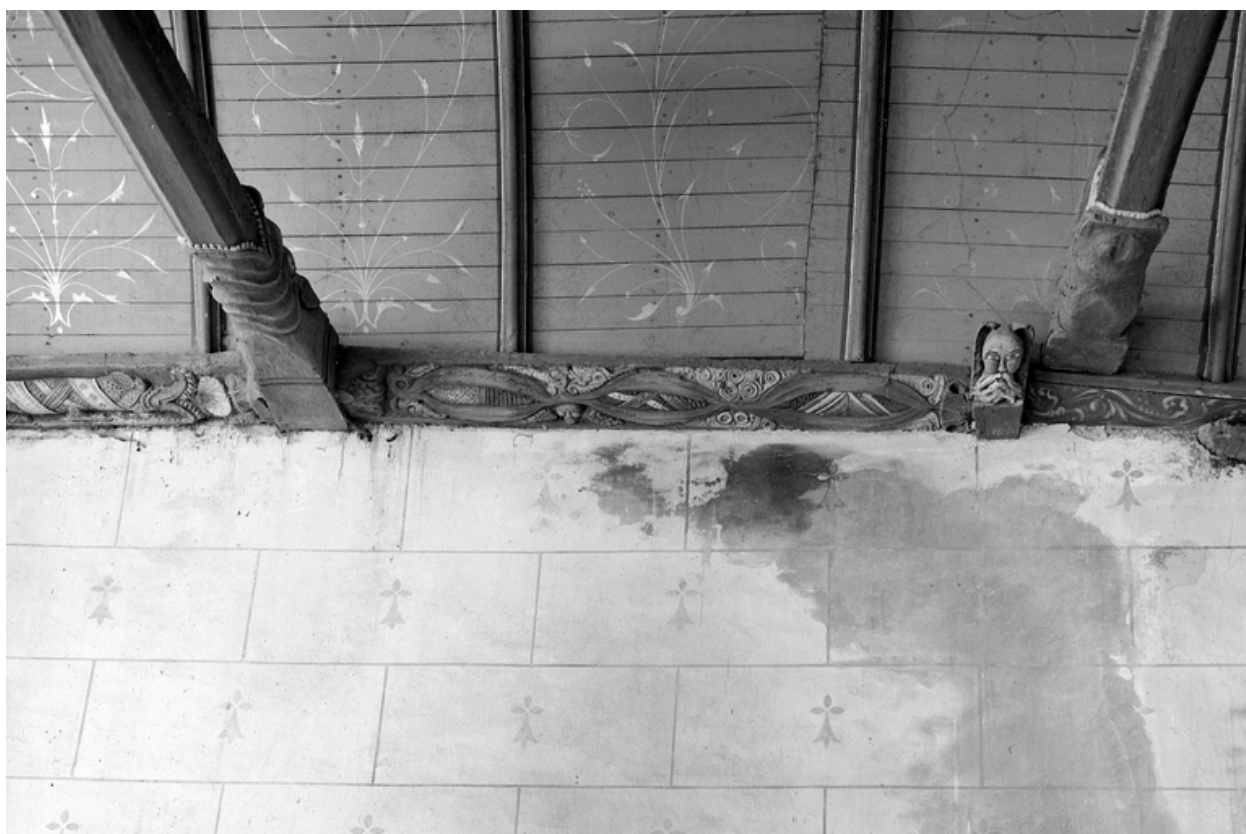
Croisillon sud, mur ouest, sablière, du nord au sud : 1er motif
