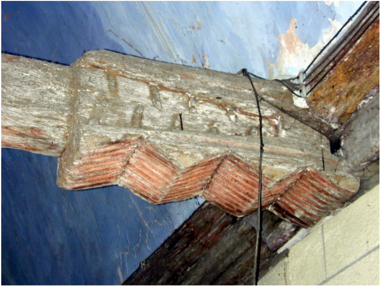
Vue intérieure ; détail
