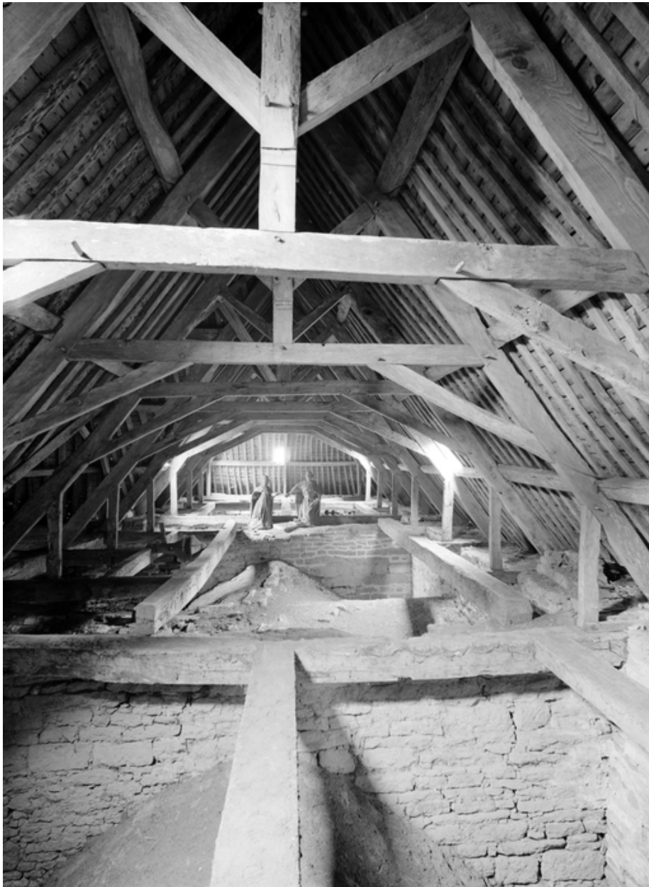
Vue générale de la charpente.
