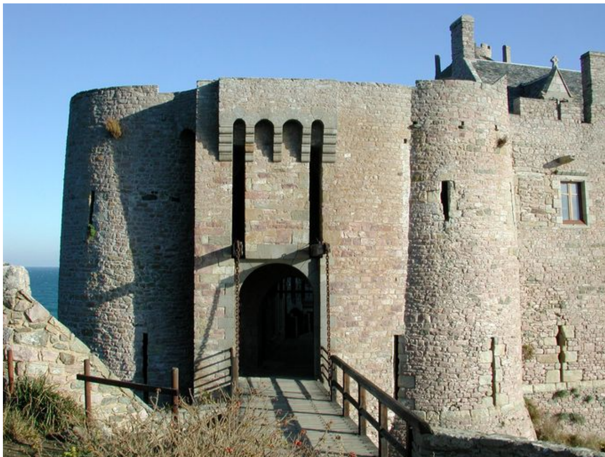
Vue du Fort La Latte
