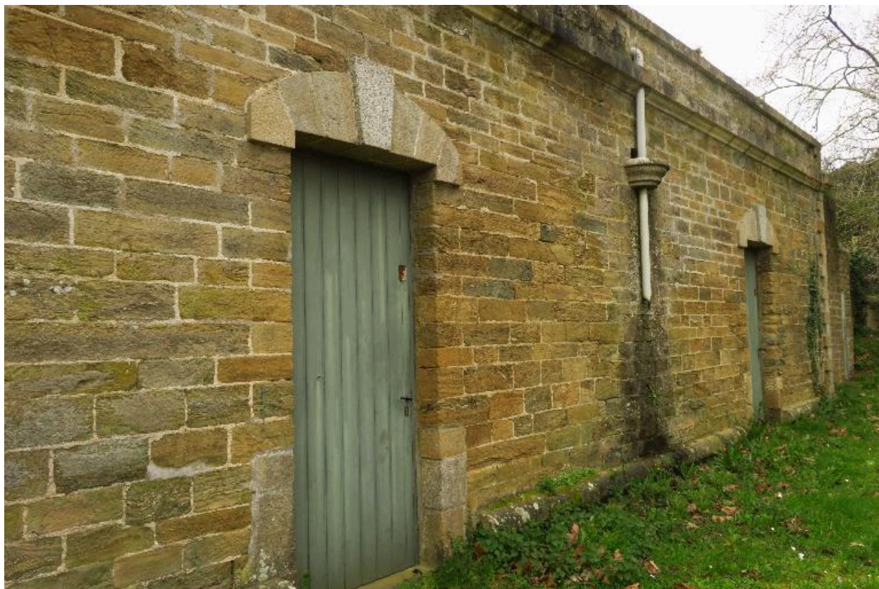
Le Palais, enceinte urbaine, réduit C, façade de gorge, partie droite.
