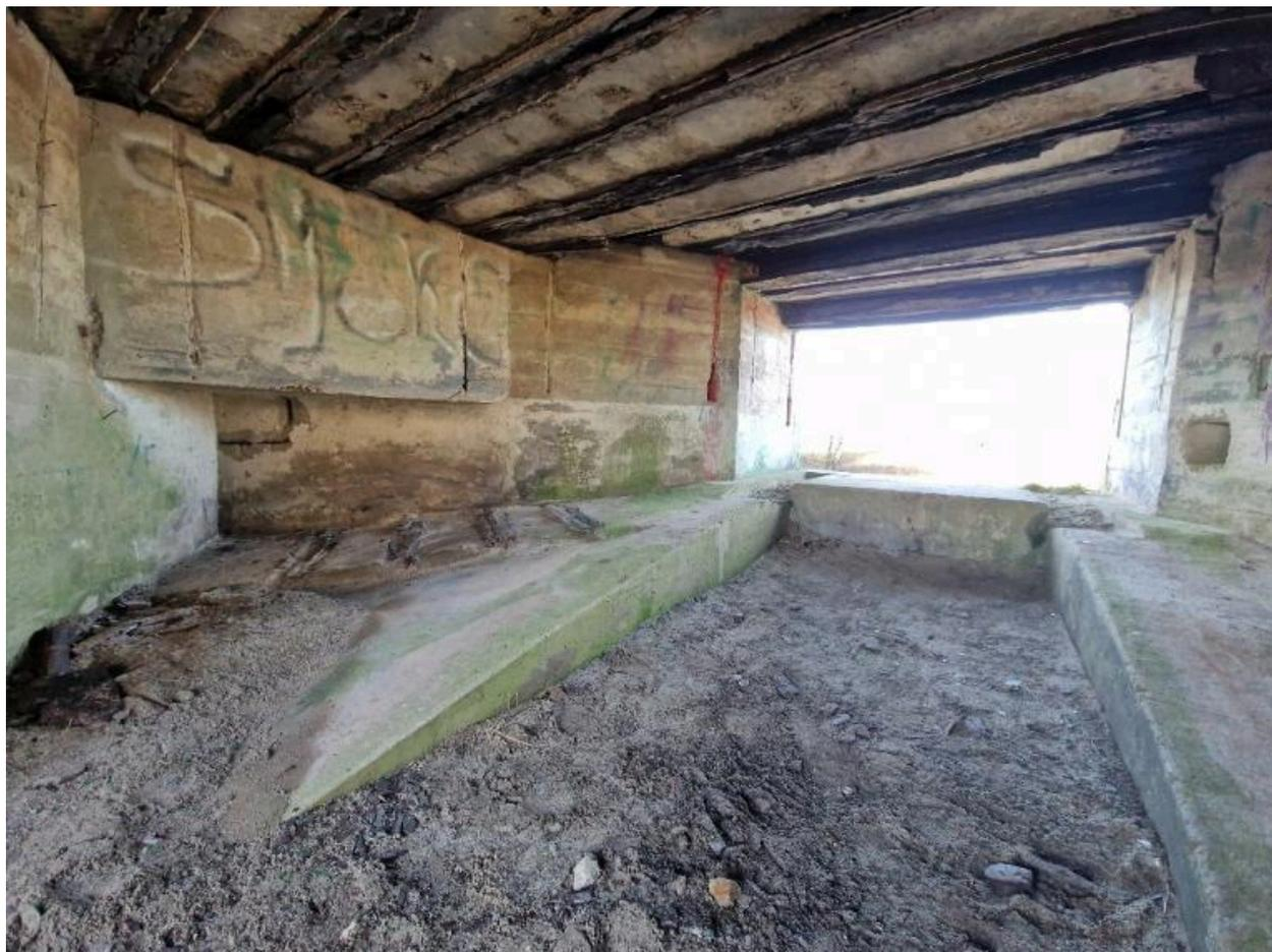
Vue de l'ensemble fortifié A 5 : bunker-casemate pour canon de 5 cm ou 7,5 cm, chambre de combat depuis l'entrée est. Rampes inclinées et rainures permettaient de faire monter puis de caler les roues de l'affût du canon
