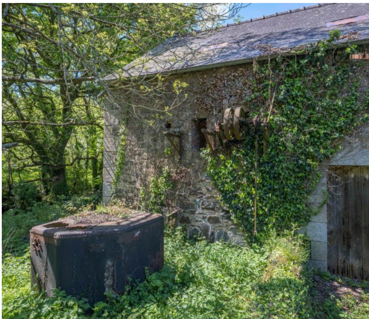
Bâtiment principal. Façade arrière sud-est et cuve à diésel
