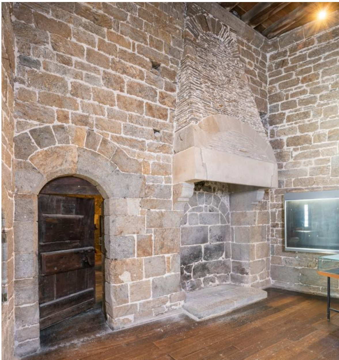
Vue intérieure de la tour Solidor : premier étage, pièce intermédiaire, porte d'accès à la tour ouest et cheminée
